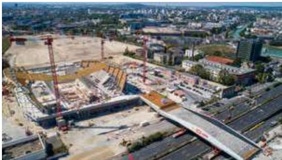
Saint Denis ▼ Passerelle Centre Aquatique Olympique sur l'A1
