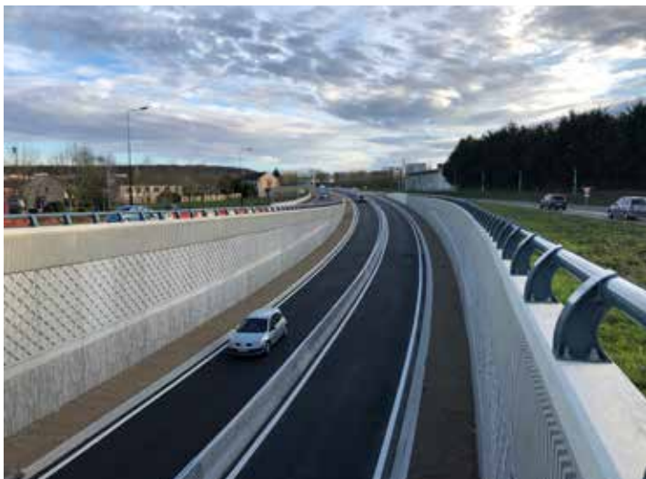
▼ RD30 - Plaisir - Aménagement et élargissement
