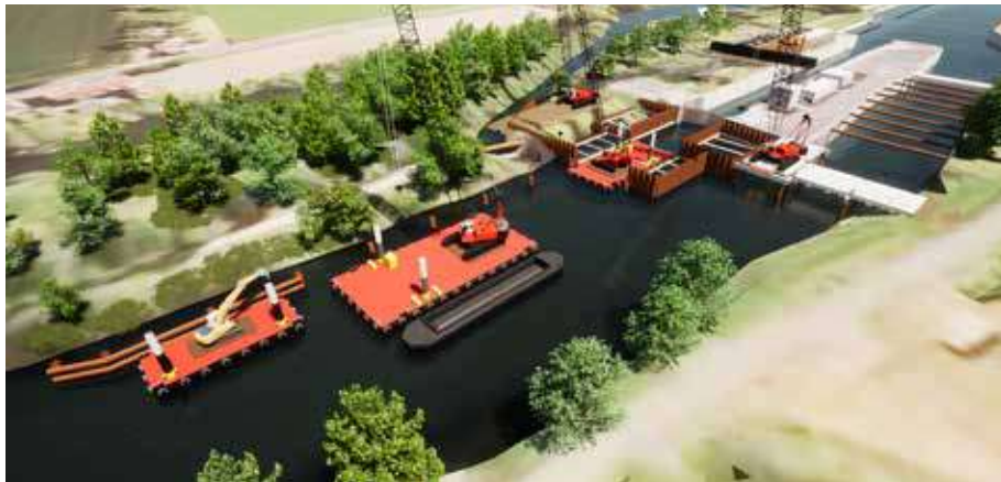
▼ Quesnoy sur Deûle – Allongement de l'écluse
