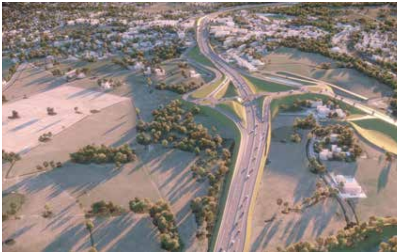
▼ RN70 - RCEA - Blanzay mise à 2 x 2 voies
