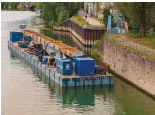
▼ Pont-rail sur le Canal Saint Denis (EOLE) Transports massifiés par voie fluviale
