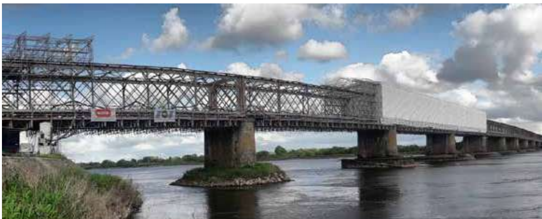
▼ Mauves-sur-Loire - Réhabilitation du Grand Pont sur la Loire et du Pont de la Pinsonnière
