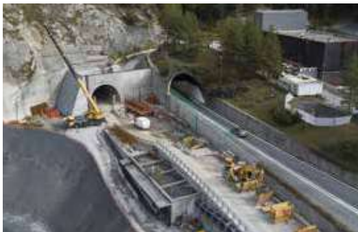
▼ Modane - Tête du tunnel de Fréjus
