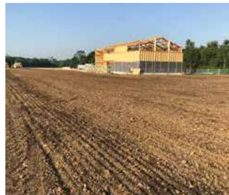
▼ Economie circulaire - Revalorisation des terres Ris-Orangis Ferme urbaine
