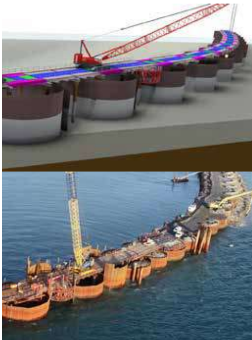
▼ Brest – Digue d'enclôture du nouveau polder
