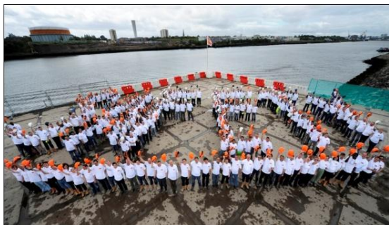
SAFETY écrit par les 310 personnes réunies le 21 juin 2011 sur le chantier de Tyne tunnel au Royaume-Uni
